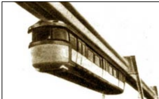
Опытный вагон SAFEGE в Шатонефе, 60-е годы
